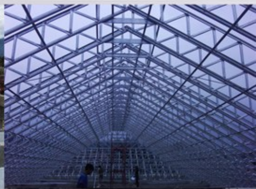
Project Gedung MKRI, Cisarua, Jawa Barat Jarak Bentang 20 Meter
